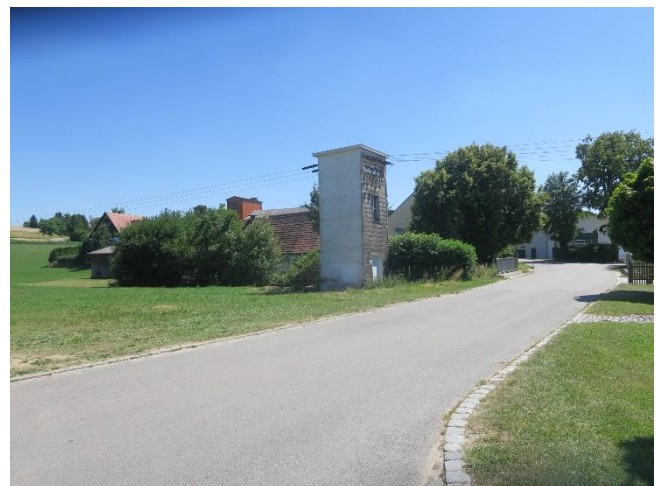
Trafogebäude an der Allakofener Straße, Blick nach Südosten
