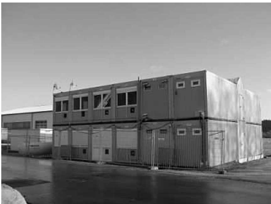
Wohn-Container-Anlage im Gewerbegebiet „Langweid“ in Elsendorf
